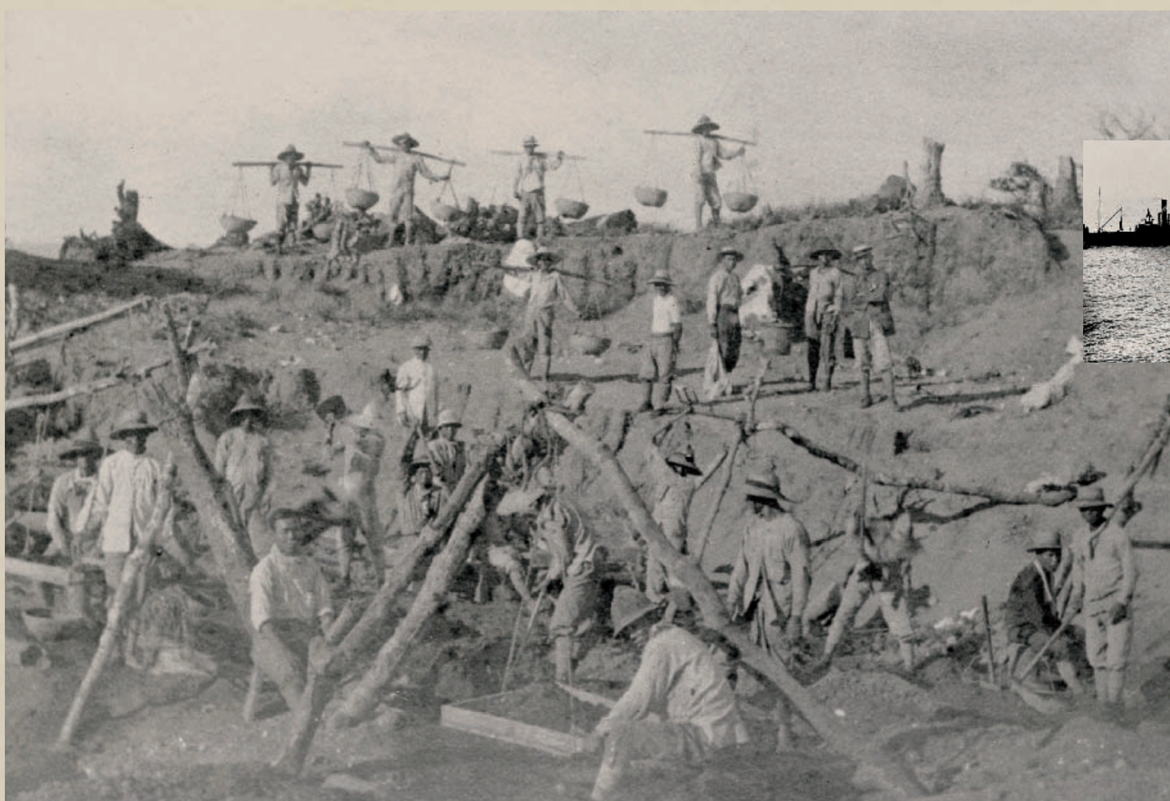
燐鉱石採掘現場。掘り起こした燐鉱石をふるいにかけている。
